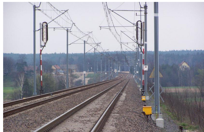
Fragment trasy kolejowej E30 (wyremontowanej z dotacji UE)
